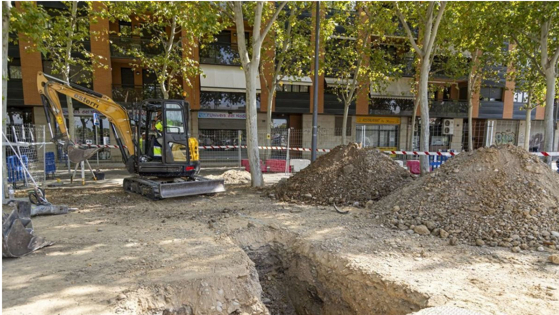
Obras para reordenar la red de aguas de la calle Xavier Puig Andreu - JORDI ECHEVARRIA
